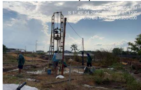
Figura 19: Poço 2 do Bairro Maturu (em construção)
