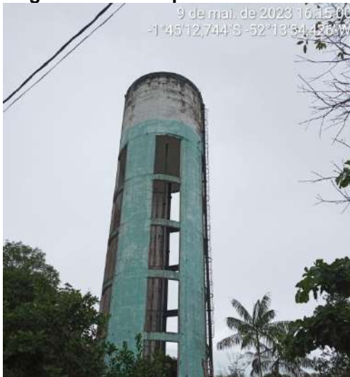
Figura 21: REL capacidade de 750 m 3
