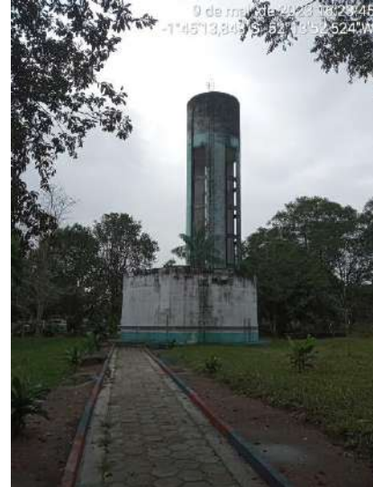
Figura 24: vista dos reservatórios
