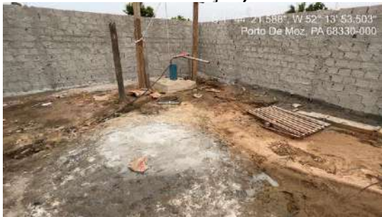
Figura 16: Poço 4 Bairro Beata (em construção)
