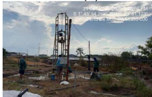
Figura 19: Poço 2 do Bairro Maturu (em construção)
