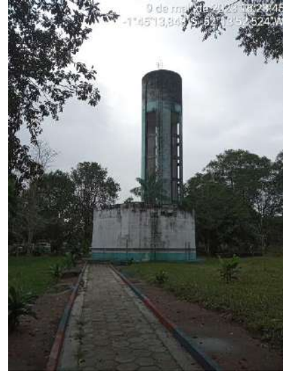
Figura 24: vista dos reservatórios
